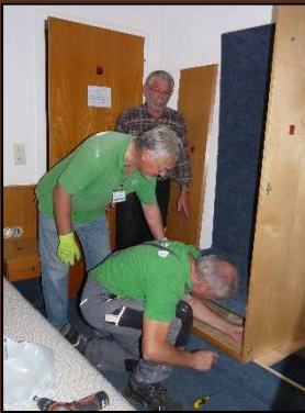
Im Rahmen unserer Sanierung werden im Gästehaus in 80 Zimmern Möbel ausgebaut
